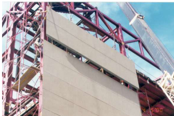
Figura 3 – Painel pré-moldado de concreto com alma em poliestireno. FONTE – SALES et al., 2001.
