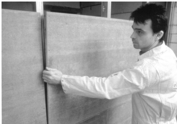
Figura 2 – Sistema de placas cimentícias. FONTE - KNAUF, 1999
