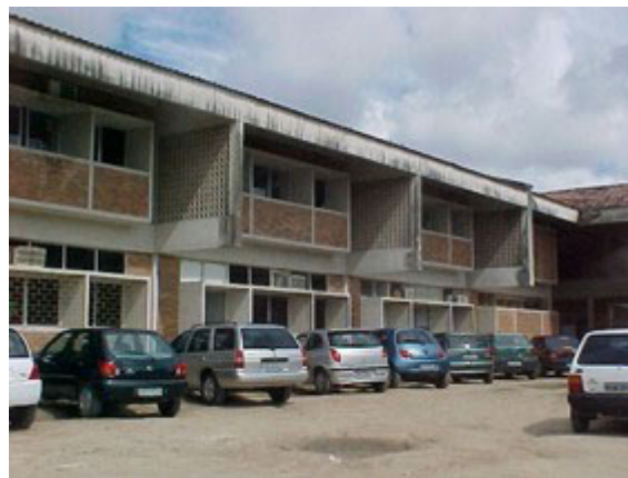
Figura 2: CTEC – Fachada Leste
