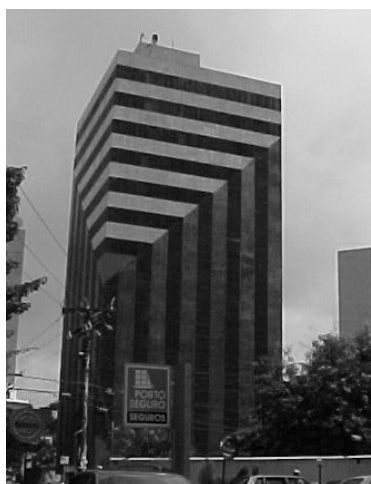
Figura 2: Os brises (linhas escuras da fachada) cobrem totalmente as janelas, proporcionando proteção total à radiação mas prejudicando a iluminação interna.
