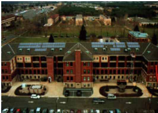
Figura 4: Exemplo de painéis como substituição de elementos da cobertura (EPA/DOE/DoD. New Jersey. 18 kWp instalado).
