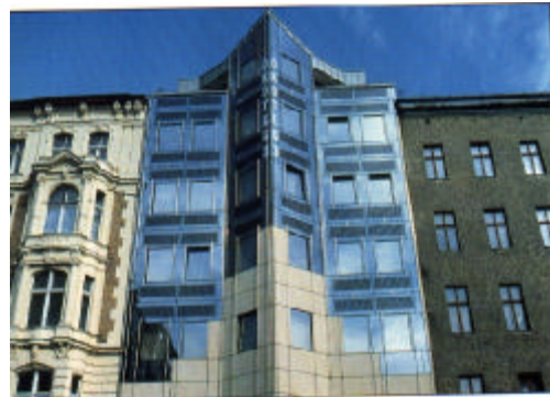
Figura 3: Exemplo de retrofit: Okotec, Office Building. Berlin, Alemanha.
