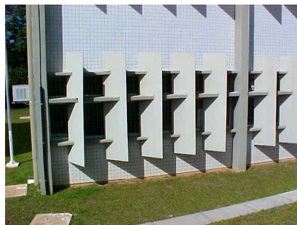
Figura 2 – Proteções solares adotadas nos prédios do departamento de Eng. Civil
