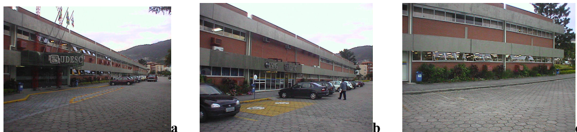
Figura 1 – Fotos externas do Bloco Principal da ESAG-UDESC: a – vista geral; b – vista aproximada da parte leste onde se localiza a biblioteca; c – vista da parte final leste do bloco com a biblioteca.
