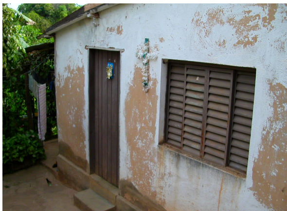
Figura 4 – Exemplo da falta de manutenção das edificações: descolamento da pintura externa, janela metálica protegida apenas por zarcão e porta de madeira com pintura inacabada.
