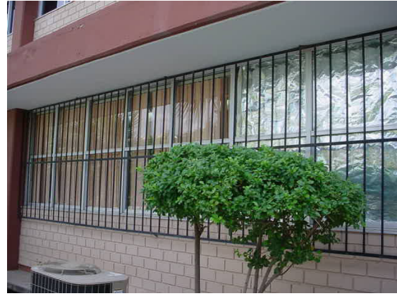
Fig. 2: Ventanas con persianas móviles y papel aluminio.
