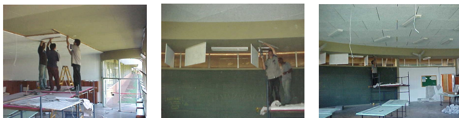
Figura 04 - Fixação das placas nas ripas; colocação dos banners; resultado final
