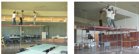
Figura 03 - Colocação dos perfis; início da montagem das placas
