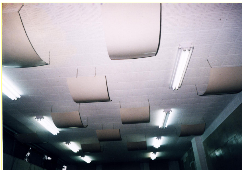
Figura 2: Curso de Música da UFSM – Difusores Parabólicos Suspensos
