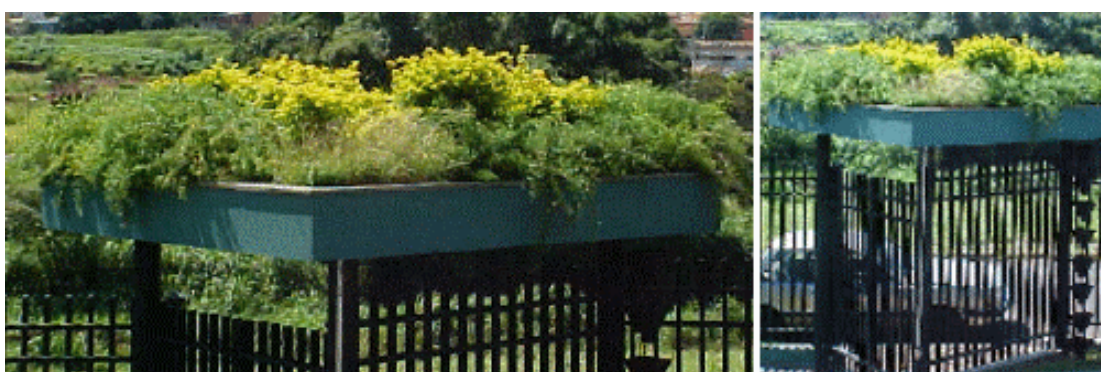
Figura 2: Vistas da guarita com Cobertura Verde (CV)
