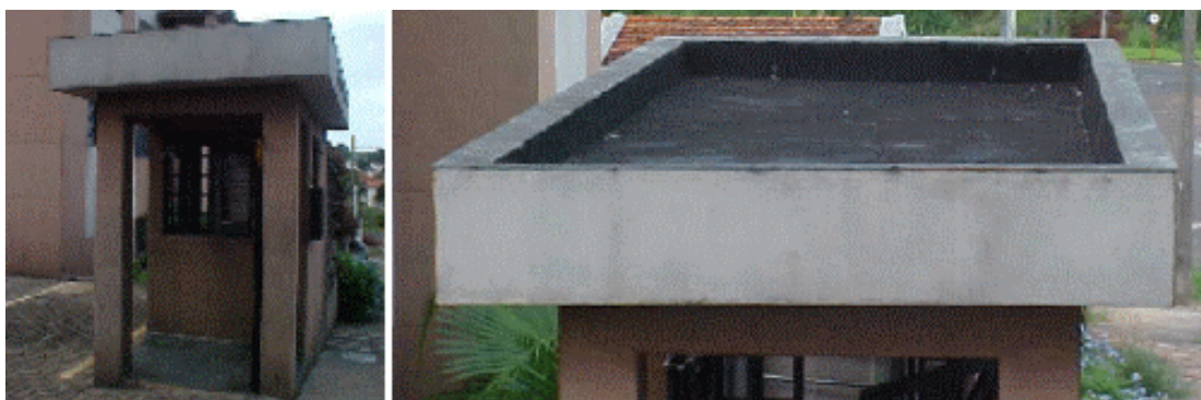
Figura 1: Vistas da guarita com cobertura em Laje Comum (LC)
