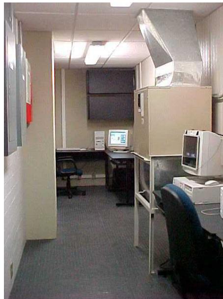
Fig. 2. LAC: Cuarto de Control
