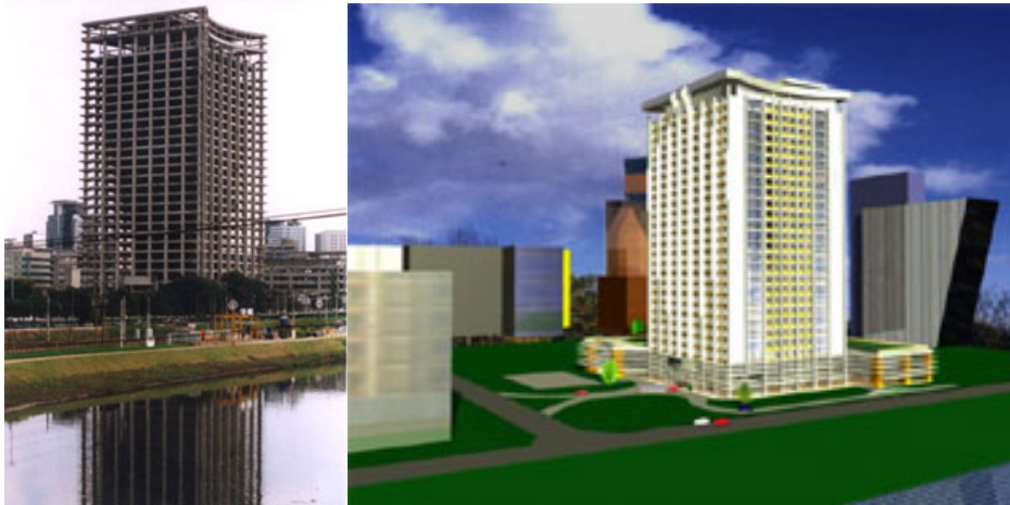
Figura 1- Estrutura existente e edifício proposto
