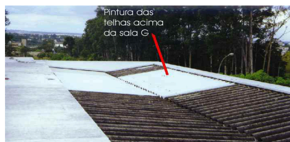
Figura 4.2-6 Pintura das telhas na sala G
