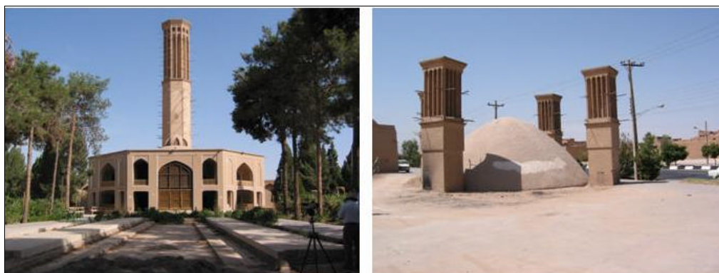
Figura 1. Captador de vento em construção situada na cidade de Yazd, Iran. Fotos: RAZAK, 2002 (não publicadas)
