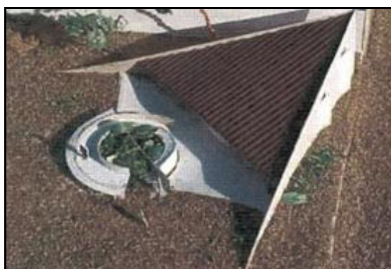
Figura 11: Vista da rampa de acesso ao átrio.
