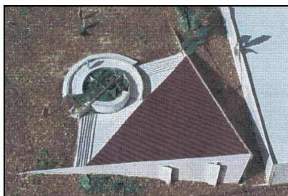
Figura 10 -Vista do templo: aletas das aberturas das fachadas laterais
