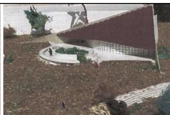
Figura 12: Vista do painel de cobogós da fachada principal
