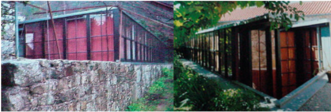
Figura 3 – Exemplo do uso de vegetação de folhagem caduca para proteção solar no verão. Fonte: TRIGUEIROS, 1997.
