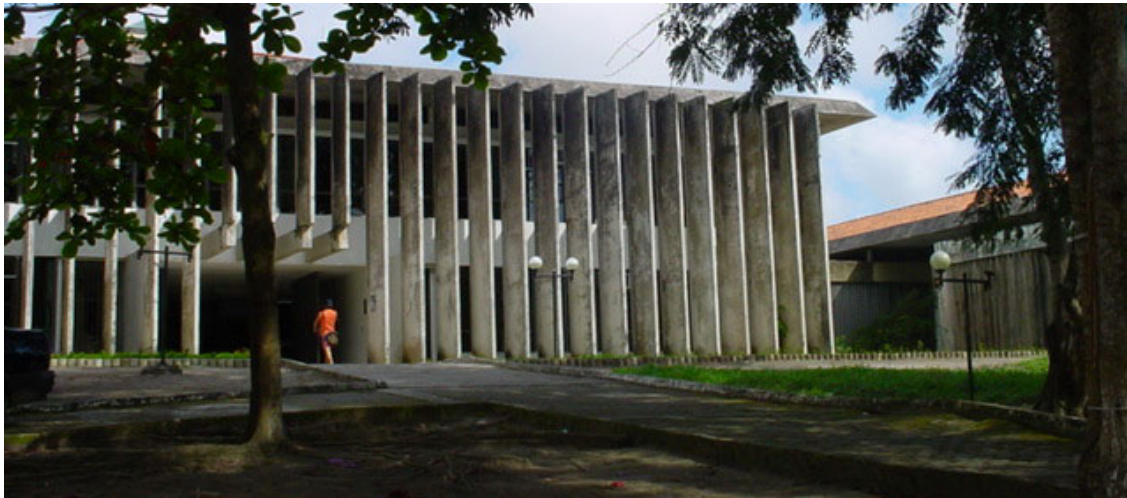
Figura 5 – Elementos verticais de proteção solar.
