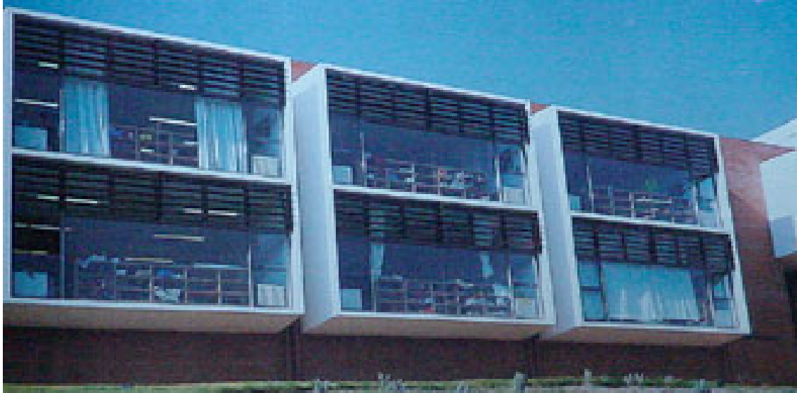
Figura 1 – Exemplo de fachada orientada a sul com elementos sombreadores no período do verão. Fonte: “Arquitectura e Vida” Telmo Miller 2002.
