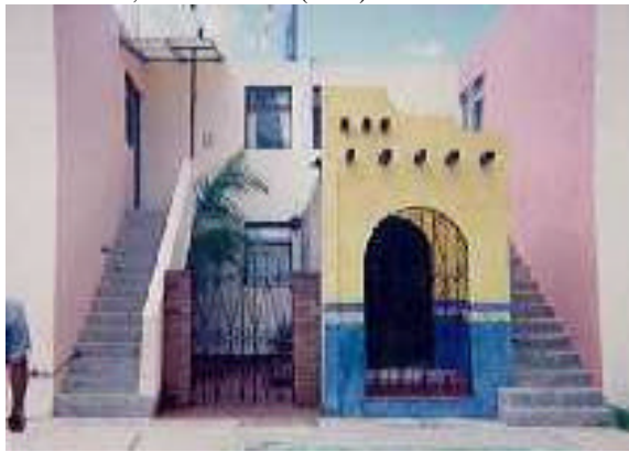
Modificaciones a la vivienda tipo, Infonavit Villa Universidad, Morelia Mich. (1980)
