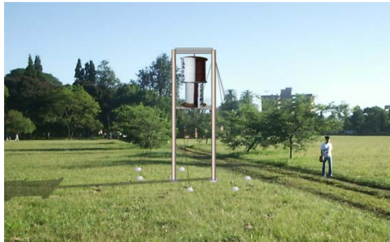
Fig. 5: Fotomontaje de la turbina instalada en el camino alternativo de ingreso al Campus de la Universidad, generado por los estudiantes. La energía producida, junto con el colector fotovoltaico instalado en la parte superior, será utilizada para la iluminación de este camino que será pavimentado por la Dirección de Construcciones Universitarias de la UNT.
