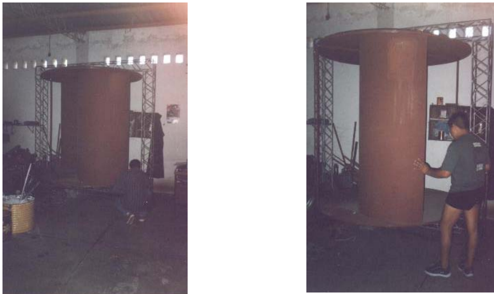
FIG. 8: Turbina Savonius para aerobombeador Kalaí en taller de fabricación
