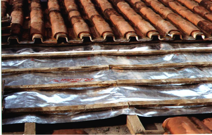
Figura 1 – Colocação das lâminas sob as ripas e telhas e acima das terças, criando duas câmaras de ar no sanduíche forro e telhado
