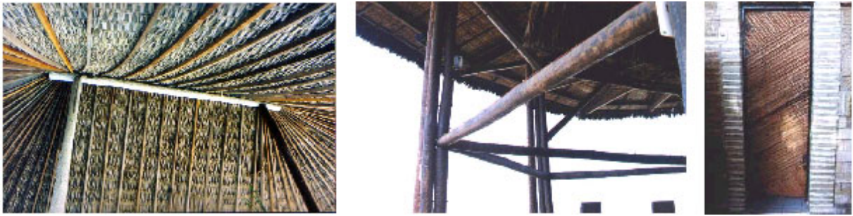
Figuras 1, 2 e 3. Estrutura, coberta e detalhes em carnaúba
