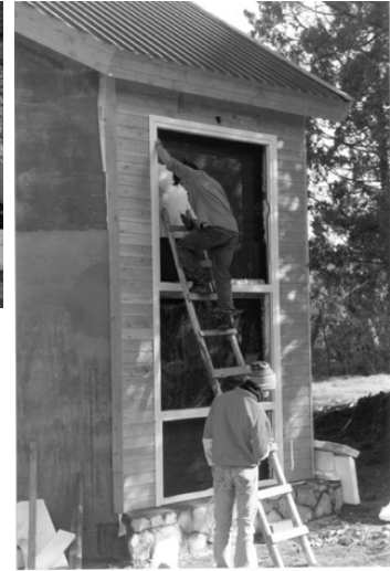
Figura 13. Muro acumulador con ventana en el paño central.
