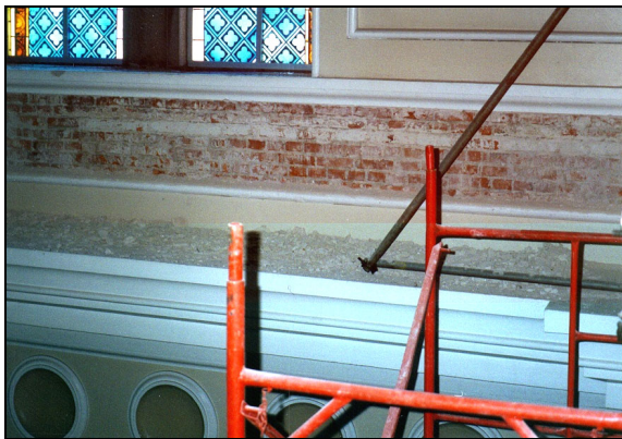
Figuras 5 e 6 – Colocação de revestimento de lã de vidro nas cornijas e fundo da igreja.
