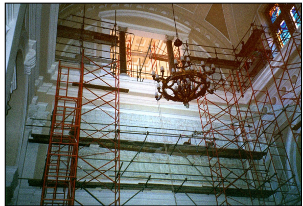
Figuras 5 e 6 – Colocação de revestimento de lã de vidro nas cornijas e fundo da igreja.
