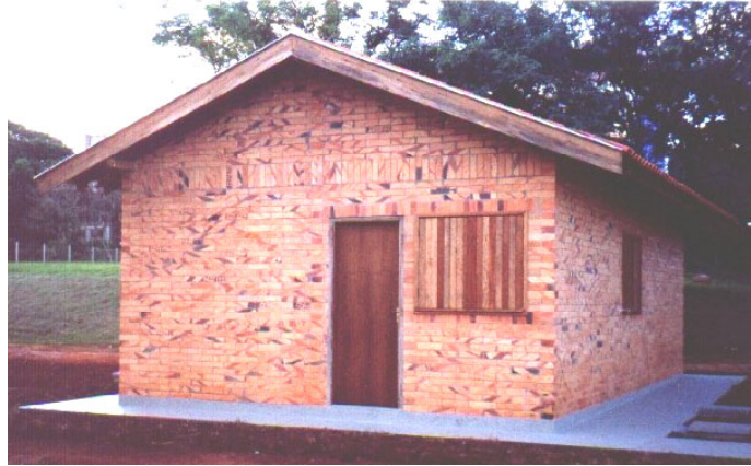
Figura 1 – Vista das fachadas Sul e Leste do protótipo habitacional para experimentos com alvenaria estrutural de blocos cerâmicos.
