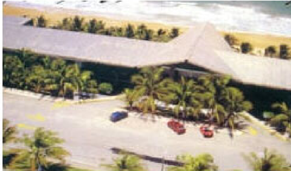
Figura 03 : Hotel com cobertura em palha de piaçava na orla de Natal. Arquitetura “regionalista” que não dispensa, no entanto, o uso do ar condicionado.
