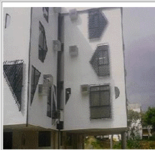
Fig. 7 Aberturas da fachada oeste com brisesoleil metálico
