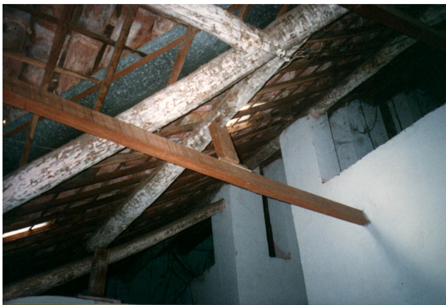
Figura 4 – Estrutura de uma cobertura em tronco de babaçu (Picos)
