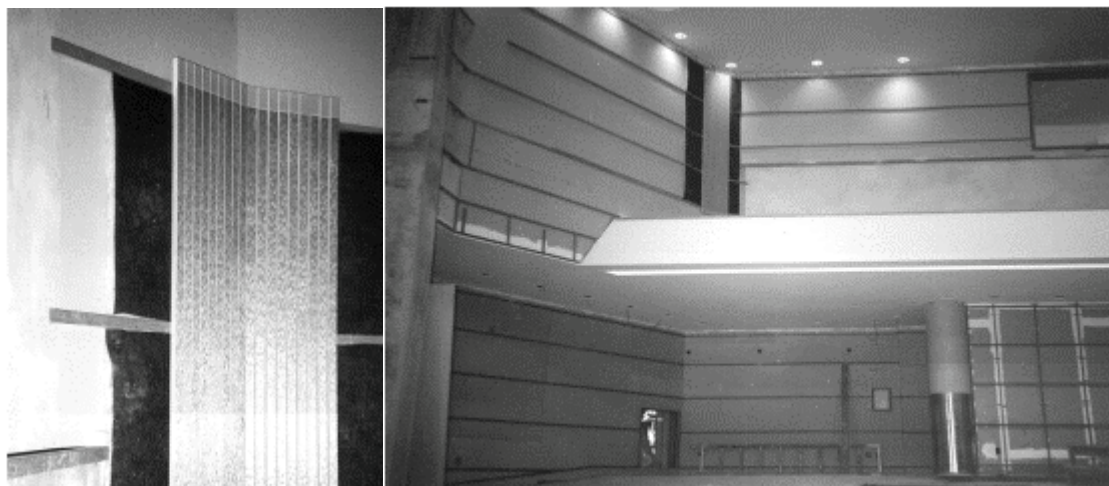
Fig. 5 Instalação Painel Absorvente Médias Frequências
