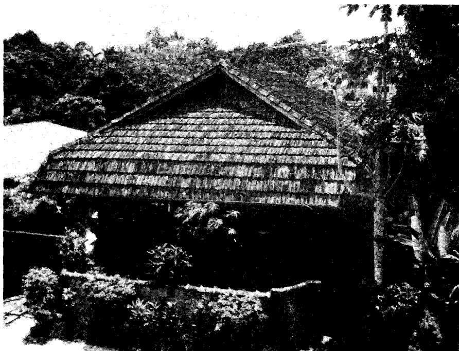
Figura 1. O beiral quebra-sol/quebra-chuva na fachada principal da residência de Monte.
